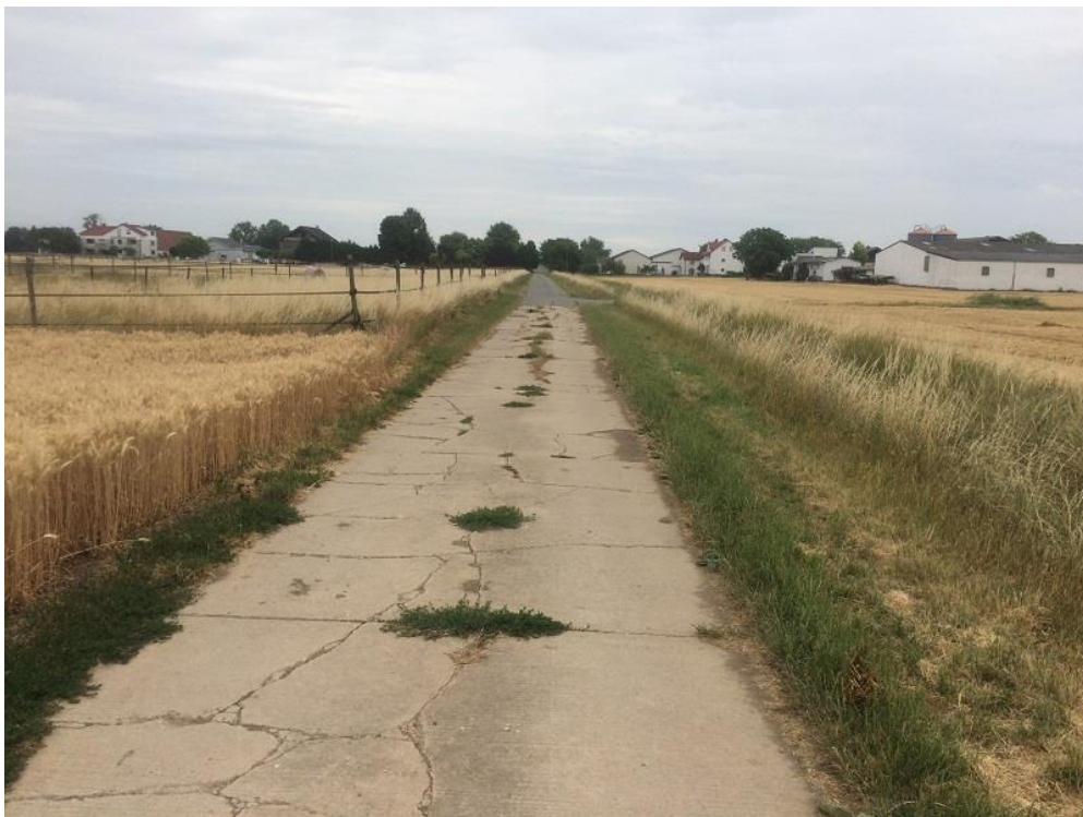
Abb. 38: Betonplattenweg (Foto F. Schrauth)
