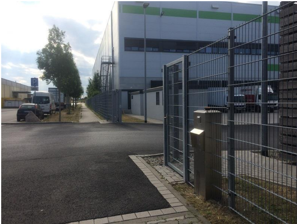
Abb. 45: Industriehalle (Dach als Singwarte) (Foto: F. Schrauth)
