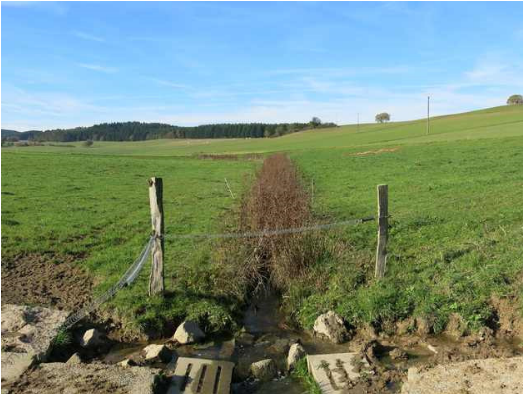
Abbildung 4: Zur Überquerung des Baches angelegte Furt mit flankierenden Holzpfählen.
