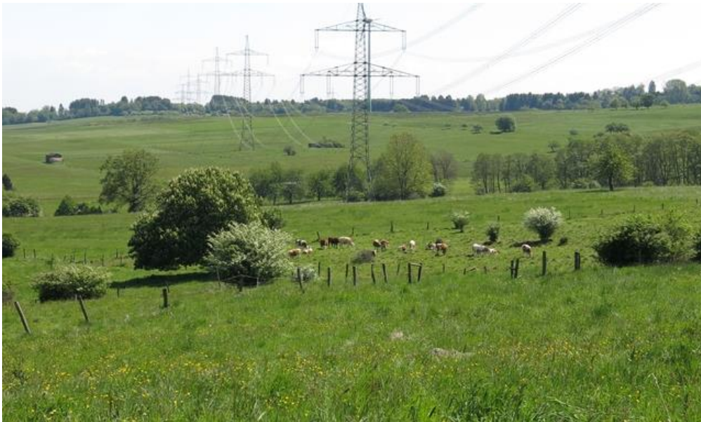
Abbildung 8: Höhergelegene, von Braunkehlchen besiedelte Rinderweiden (Bereich „Gellertswies“, „Wasserstücker“) westlich von Münchhausen. In den entsprechenden Abschnitten ist auf eine möglichst niedrige Besatzdichte während der Brutzeit zu achten. Außerdem sollten im Bereich der „Gellertswies“ (Flurstück 2/1, Flur 26) die vorhandenen Gehölze reduziert werden.
