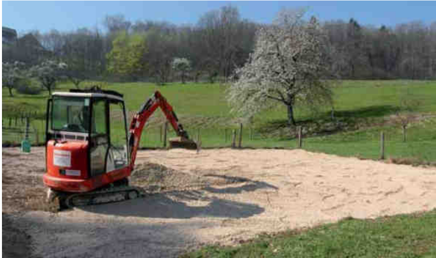
Abbildung 30: Zur Optimierung von Gartenrotschwanz-Habitaten wird in der Schweiz auch „schweres“ Gerät eingesetzt. Hier wurde Oberboden abgetragen und die Fläche nachfolgend mit mageren Substraten verfüllt (Bildquelle: SCHUDEL 2009).
